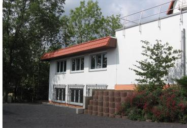
Zweigeschossiger Anbau 11 x 7 m mit komplizierter Unterfangung des vorhandenen Gebäudes, Gründung auf Streifenfundamenten und Stahlbetonplatte, Wände aus Stahlbeton bzw. Mauerwerk mit Vollwärmeschutz, Decken aus Stahlbeton, bekiestes Flachdach, Ausführung unter äußerst beengten Verhältnissen.
