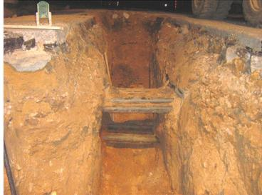
Herstellung der Schmutzwasseranbindung der Grundstücke Pönitzer Weg 13 und 15 bis zum Knotenpunkt B 87 / K 7422 als Kanal DN 250 Stzg. (157 m) einschl. dem Setzen zweier Schächte DN 1000 und Herstellung der Hausanschlüsse in Stzg. DN 150. Während der Ausführung wurde ein verdämmter Fernwärmekanal angetroffen, welcher abgebrochen wurde.
