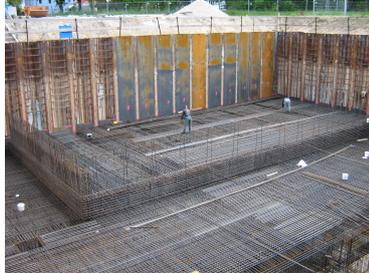
Neubau einer Trinkwasseraufbereitungsanlage aus Stahlbeton (ca. 3.900 m<sup>3</sup> Beton C 30/37 XC4 XD1 XF1 XA1 mit CEM III/ B und 810 to Betonstahl) in Staaken, Gesamtabmessung: ca. 27,5 x 24,5 m, mehrgeschossiges Gebäude mit zwei Untergeschossen, einem Erdgeschoss und einem Obergeschoss, Untergeschosse bis ca. 9,00 m unter OK Gelände, Ausführung in Sichtbetonqualität. Schalhöhe Decke 12,50m. Die Aufbereitungsleistung beträgt 1.200 m<sup>3</sup>/h.
