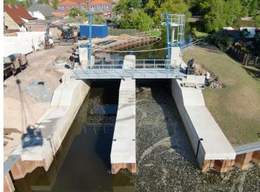
Die neue 2-Feld-Wehranlage mit jeweils 4,25 m Klappenbreite wird direkt am Altstandort in 2 Bauabschnitten errichtet. Während des Baus des 1. Abschnittes verbleibt die Altanlage in Betrieb und wird erst im Zuge des 2. Bauabschnittes abgebrochen, während das erste Feld der neuen Anlage schon im Handbetrieb gefahren wird. Die Wehranlage befindet sich in unmittelbarer Nachbarschaft zu Wohnbebauung.
